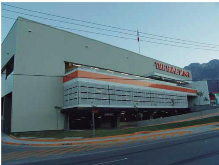
La aplicación arquitectónica de louvers en fachadas de naves industriales reduce los costos de construcción al permitir la disminución de altura en los muros, a la vez que ayuda a mejorar las condiciones de micro clima al interior de las naves por efecto de la ventilación inducida que proporcionan.
