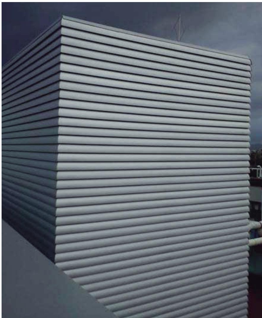
Las fachadas ventiladas suponen una solución idónea para la rehabilitación de fachadas en edificios.
