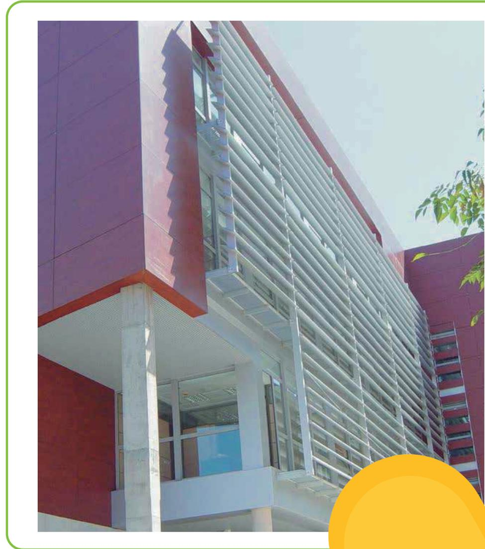
DUNE AIR SYSTEM esta especialmente diseñada para la instalación en zonas donde se requiera ocultar las máquinas de aire acondicionado dado que el área libre de ventilación es del 70 % que garantiza un alto flujo óptimo para el buen funcionamiento de cualquier equipo.
